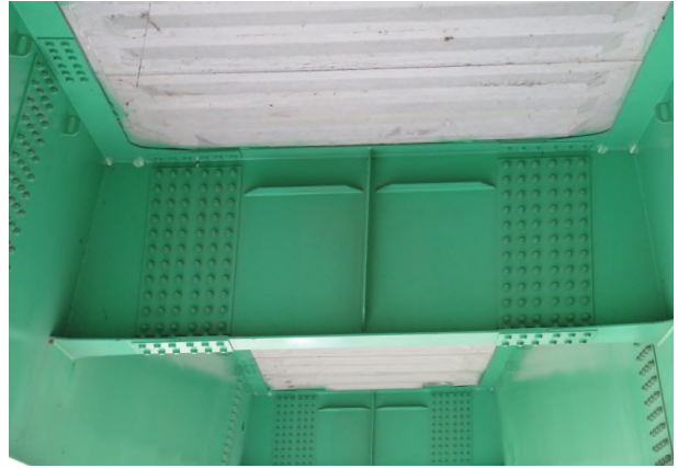
거더 및 가로보 전경
