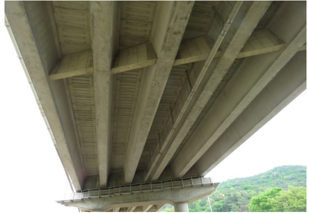
거더 및 가로보 전경
