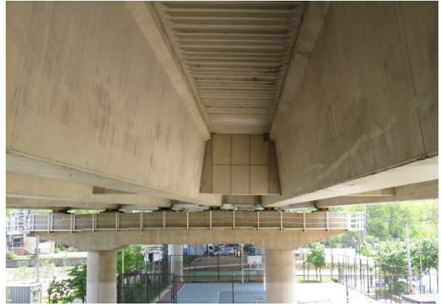
거더 및 가로보 전경
