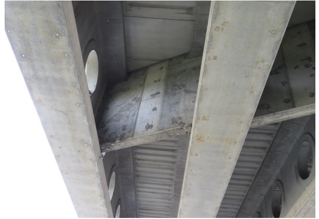
거더 및 가로보 전경
